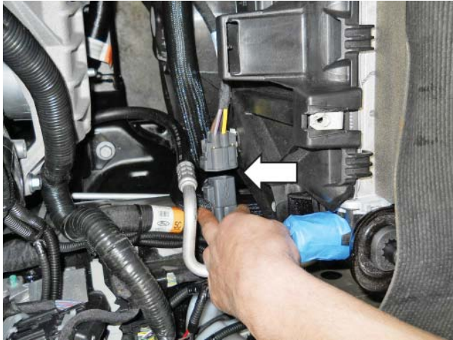
Fan electrical connector
